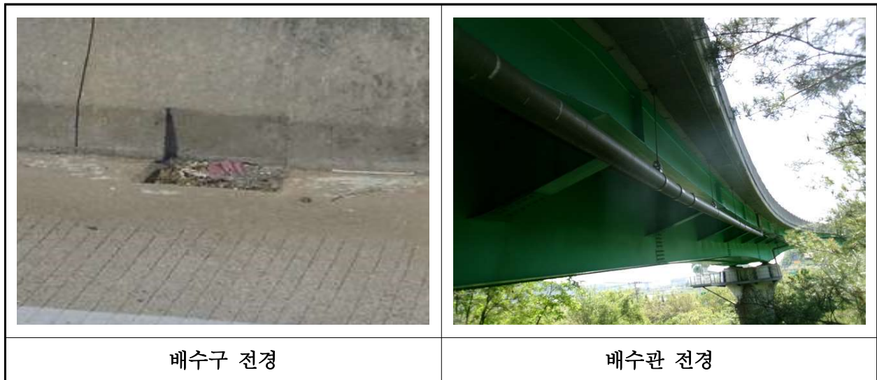
【사진 33.3.22】 배수시설 전경
