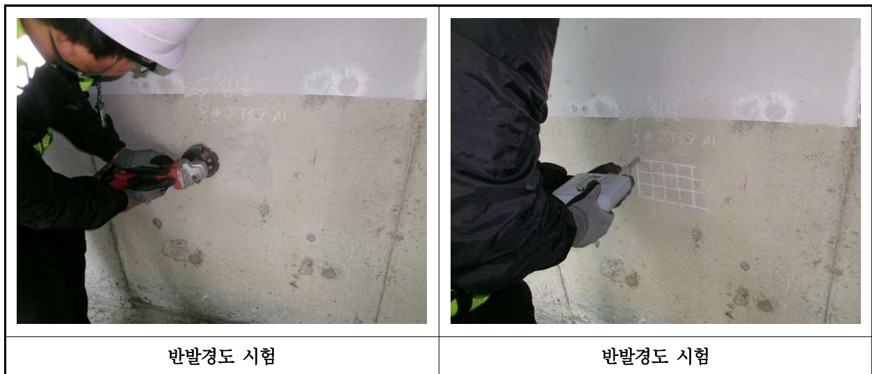
【사진 33.4.2】 반발경도시험 현장사진
