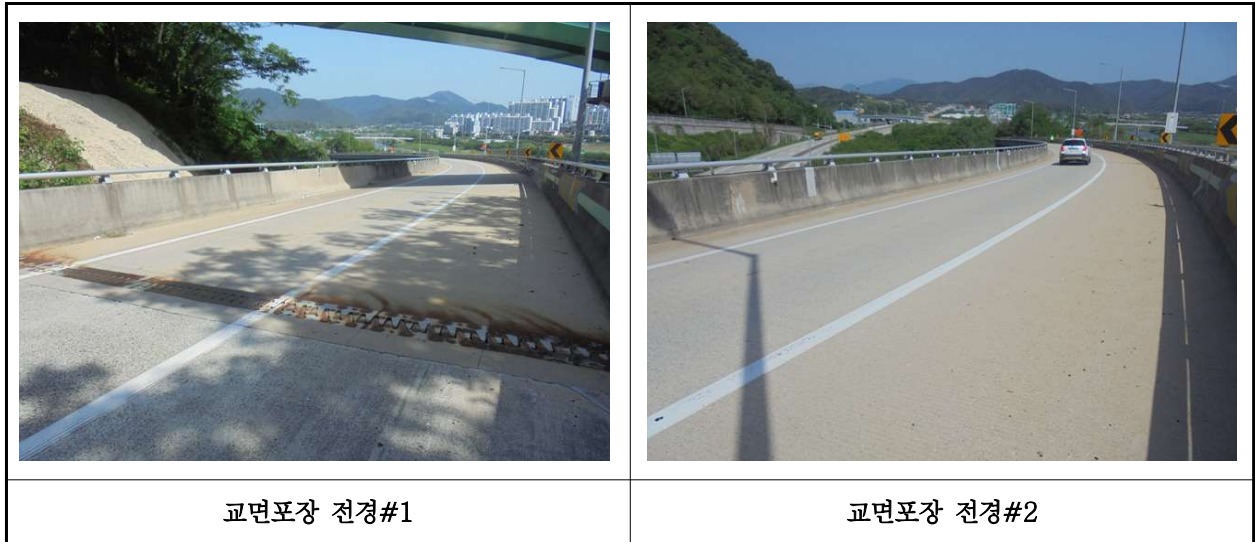
【사진 33.3.20】 교면포장 전경
