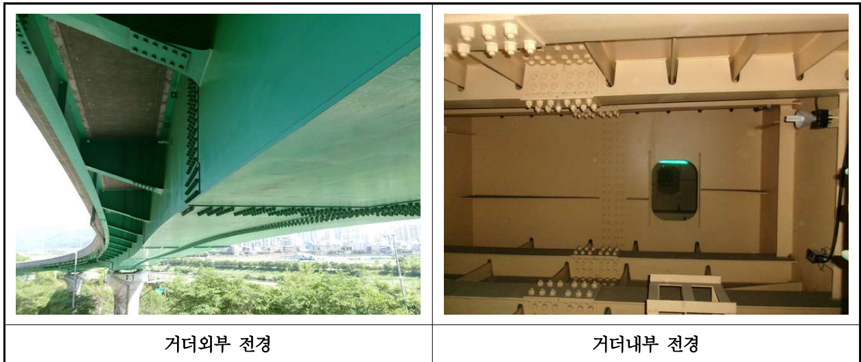
【사진 33.3.4】 거더 전경
