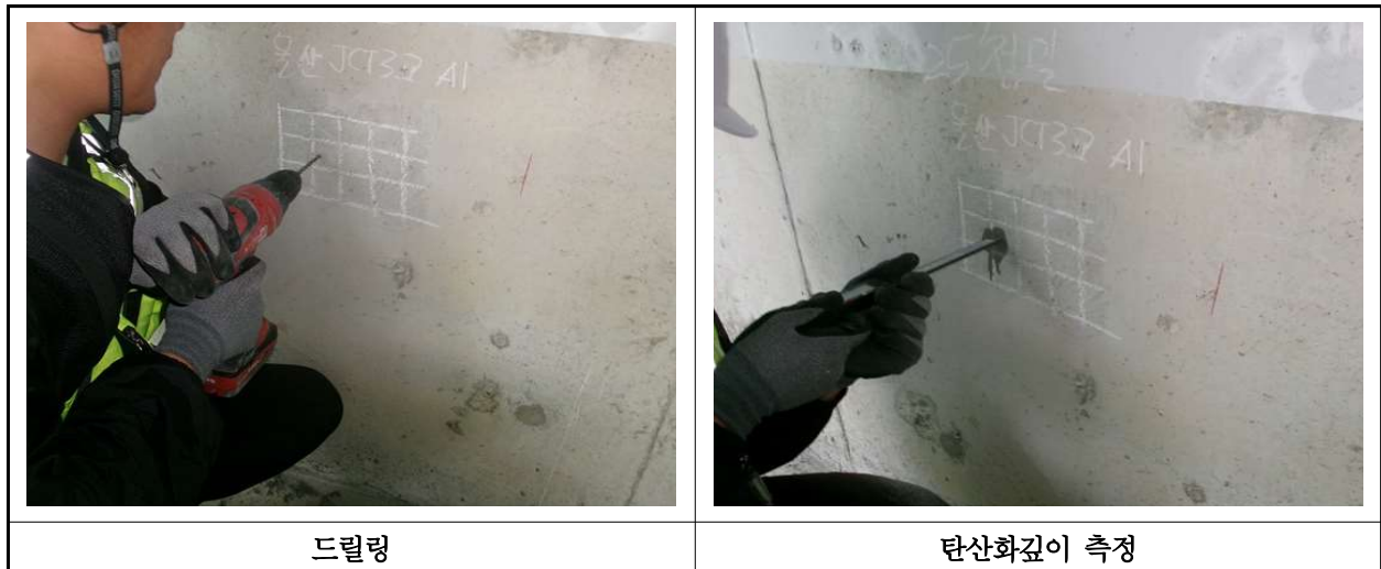
【사진 33.4.3】 탄산화 깊이 측정 현장사진
