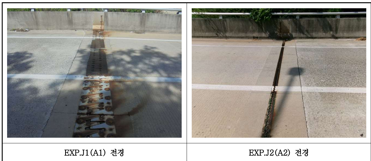
【사진 34.3.17】 신축이음장치 전경
