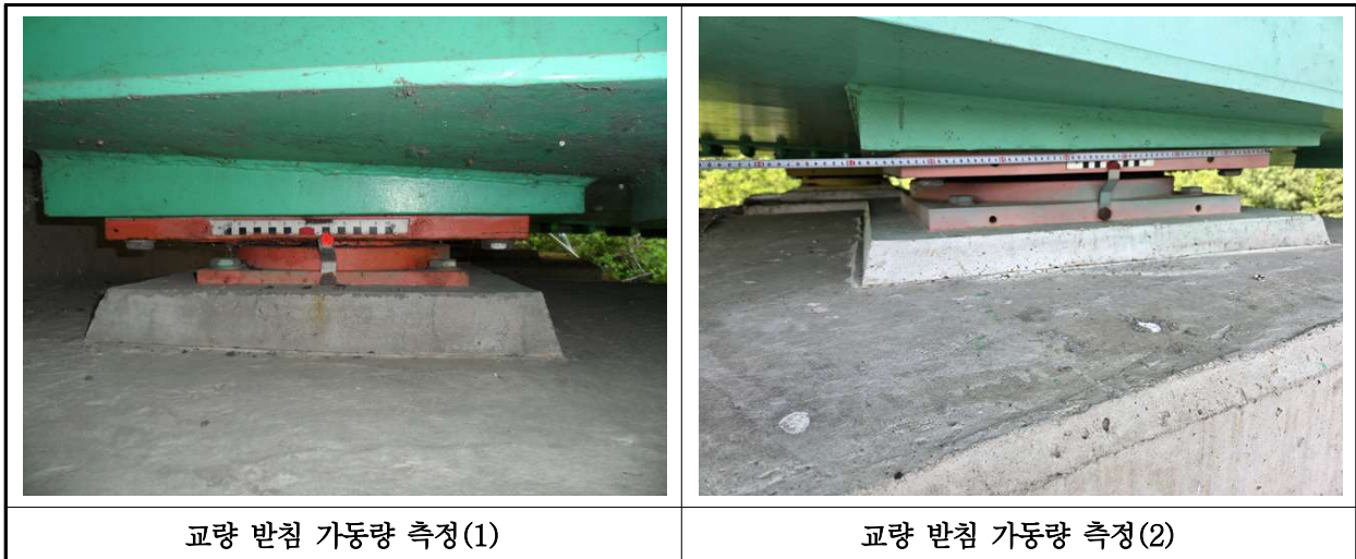
【사진 33.3.16】 교량받침 이동량 측정
